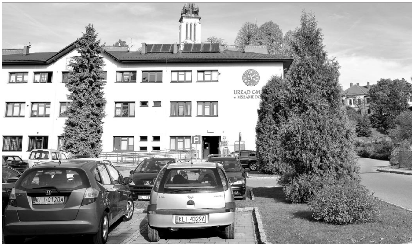
Budynek Urzędu Gminy Mszana Dolna
