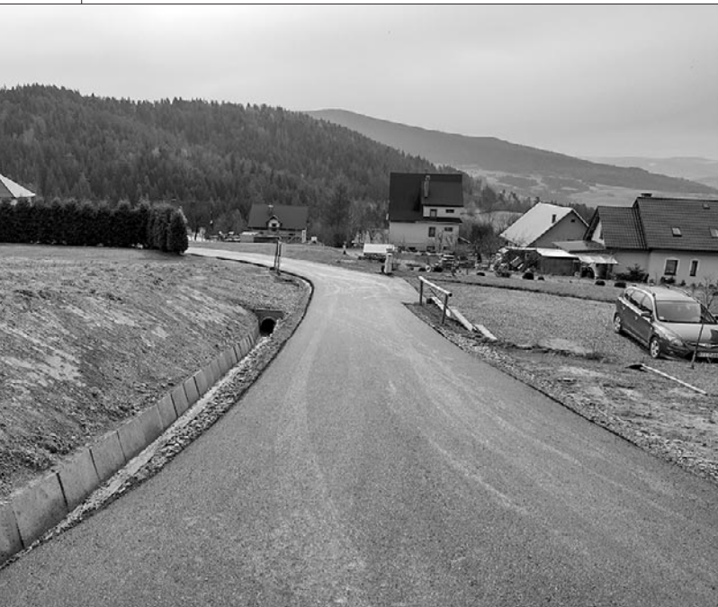
Droga do osiedla Rażne w Kasince Małej
