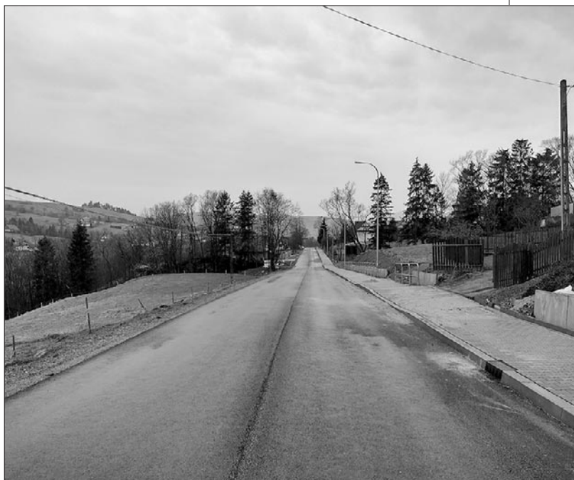
Droga powiatowa w Łętowie
